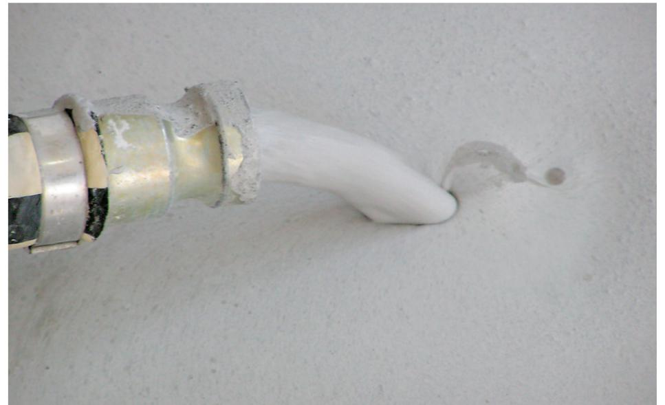
Der Calciumsulfat-Fliessestrich muss nur eingepumpt und mit der Schwabbelstange verteilt werden, danach breitet er sich selbsttätig aus und verdichtet sich auch selber. So werden ohne grosse körperliche Belastung Tagesleistungen von bis zu 1500 Quadratmetern möglich.
