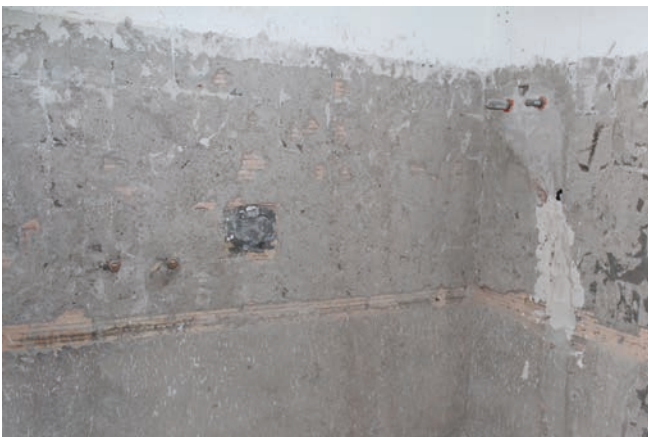
Alte Fliesen wurden entfernt und Fixit 632 Rapid Ausgleichs- und Renovationsputz aufgebracht.
