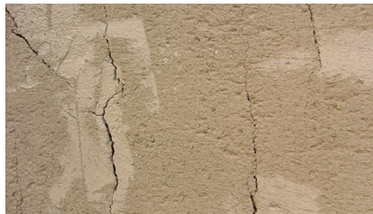
kleine Schwindrisse im frischen Zustand
