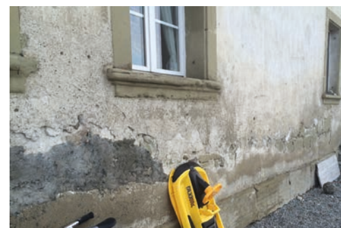
aufsteigende Feuchtigkeit
