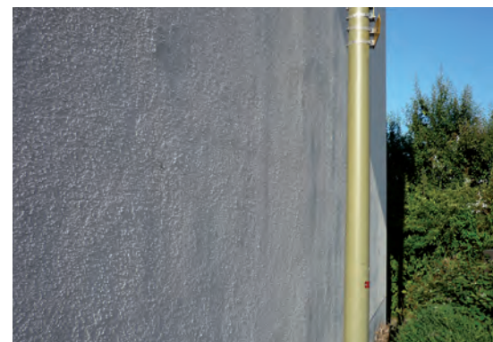
Marquage des joints des plaques
