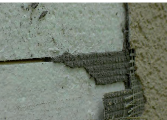
Mortier dans le joint du panneau
