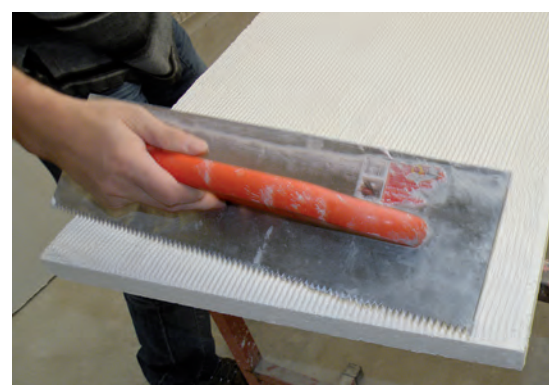
Application de la colle avec la truelle dentée
