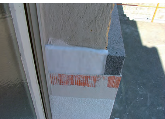
Embrasure avec Aerogel et structure crépie
