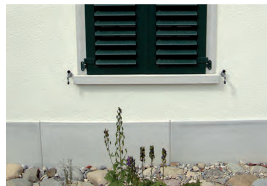
Soubassement fibro-béton (GFB)
