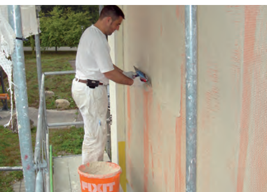
Enduit de fond avec enrobage du treillis
