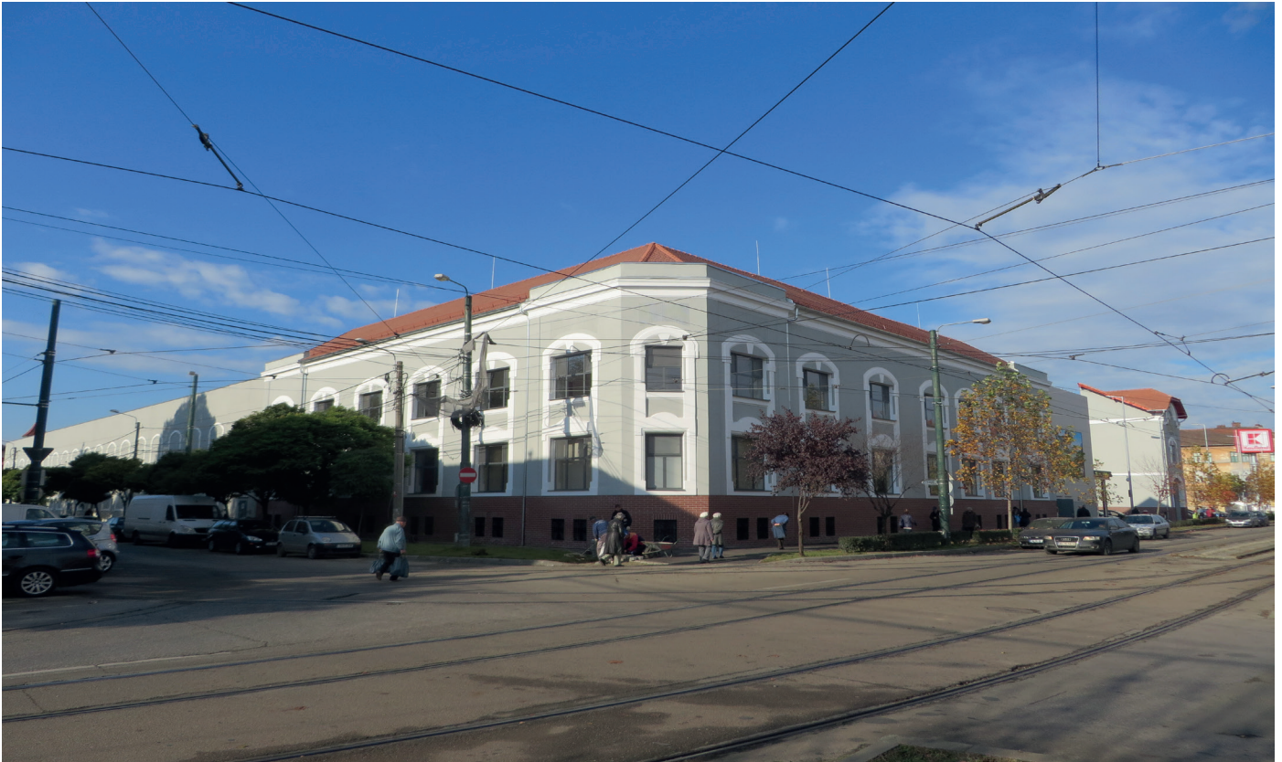
Sisteme renovare și asanare
