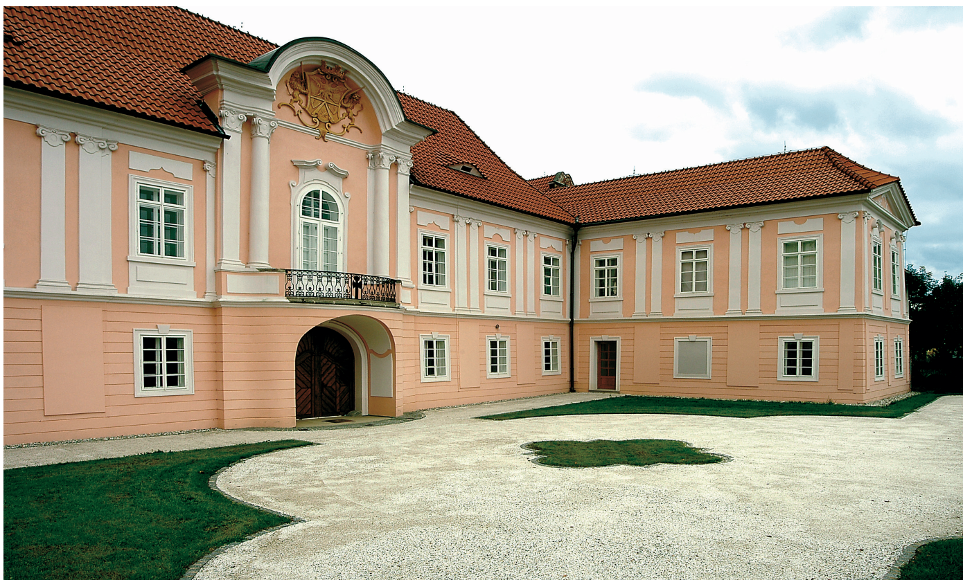
Sanace a renovace
