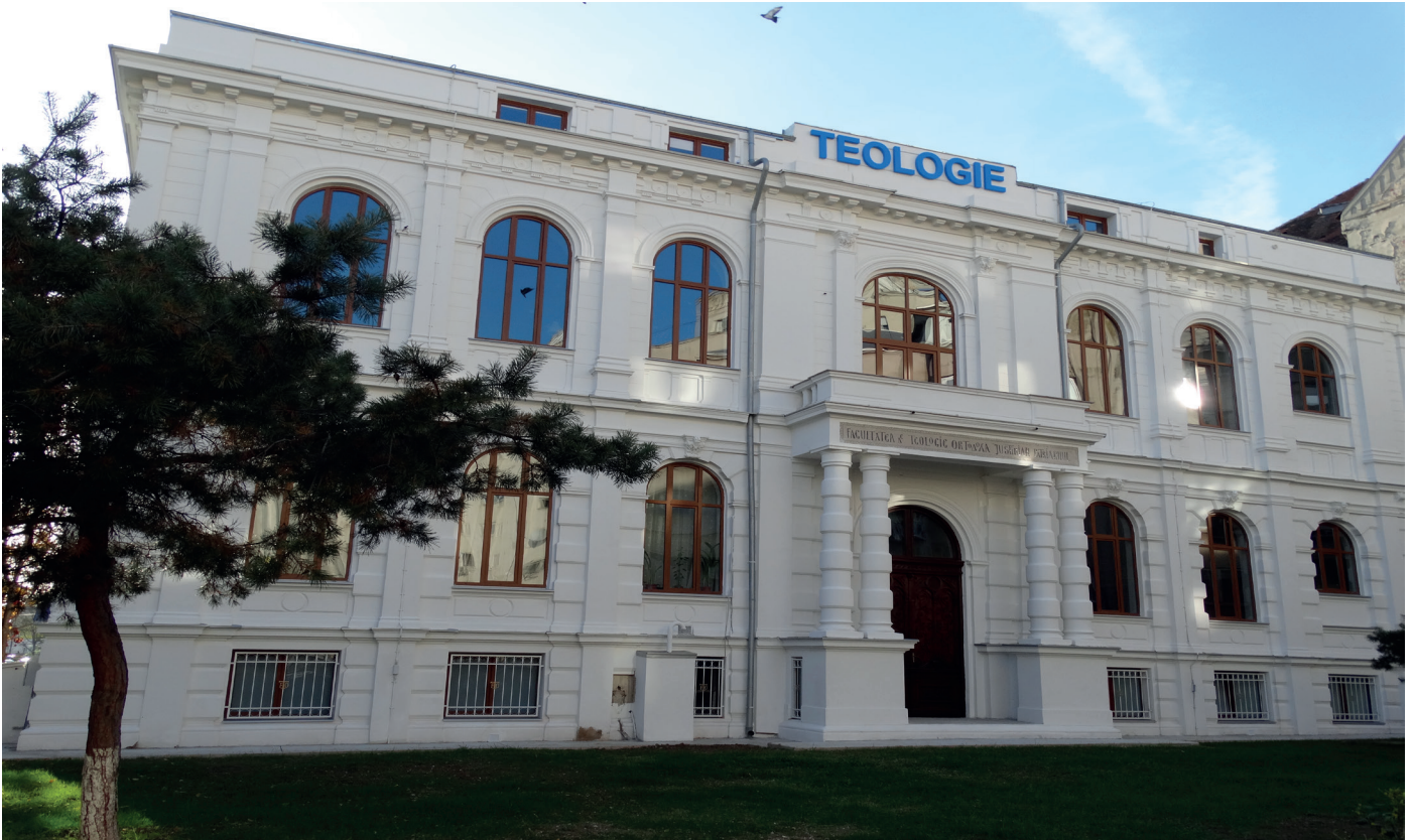
Sisteme renovare și asanare
