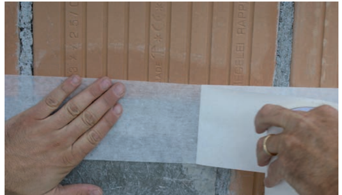
Trennvlies aufkleben Coller le non-tissé de séparation
