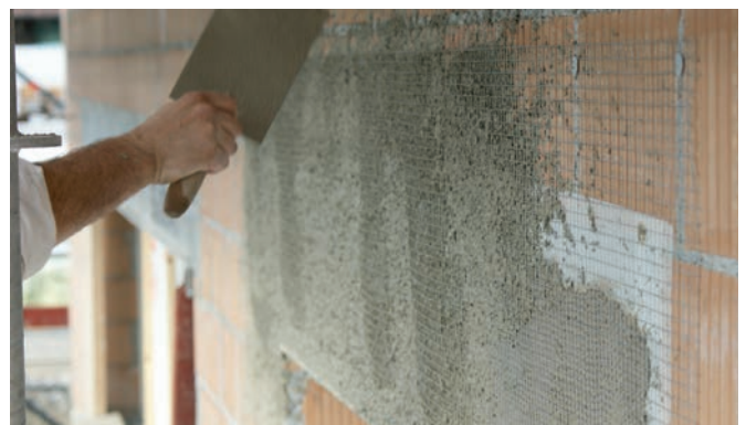
Zementmörtelanwurf Prégiclage au ciment
