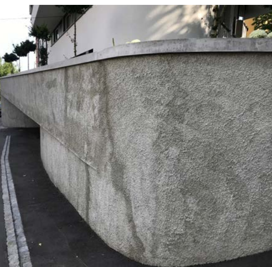
Umfassungsmauer mit Fixit 565 Natursteinmörtel verputzt, roh belassen
