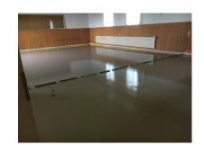
Sanierung des alten Holzbalken- sowie Beton-Fussbodens im grossen Saal. Die Balkenzwischenräume wurden mit Fixit Schaummörtel 8040 POR verfüllt. Nach Austrocknung wurde eine Trittschallfolie darüber verlegt und hierauf, sowie im Verbund auf dem angrenzenden alten Betonuntergrund (vorgestrichen mit Fixit 492 Megagrund), Unterlagsboden Fixit 830 evo eingebracht.
