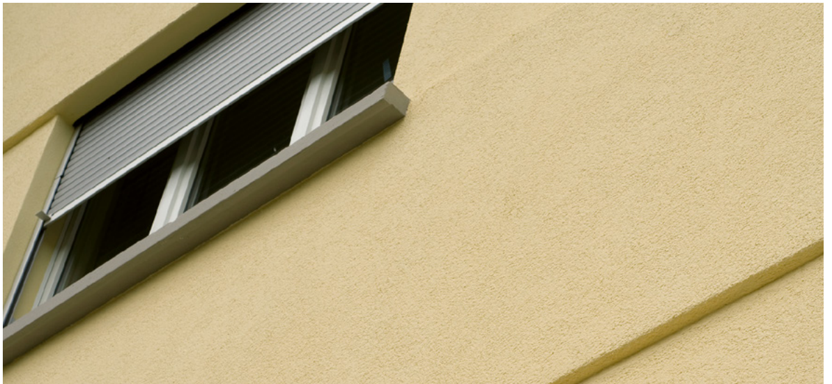
Mehrfamiliengebäude in Biel, Objektgröße 1 037 m 2 . Systemaufbau: Dämmung mit Steinwolle, 160 mm, Grundbeschichtung Pura Einbettmörtel 426, Netzeinbettung Pura Einbettmörtel 426, Deckbeschichtung Pura Edelputz 402 Vollabrieb, 2.0 mm, Anstrich 2K Silikatfarbe.
