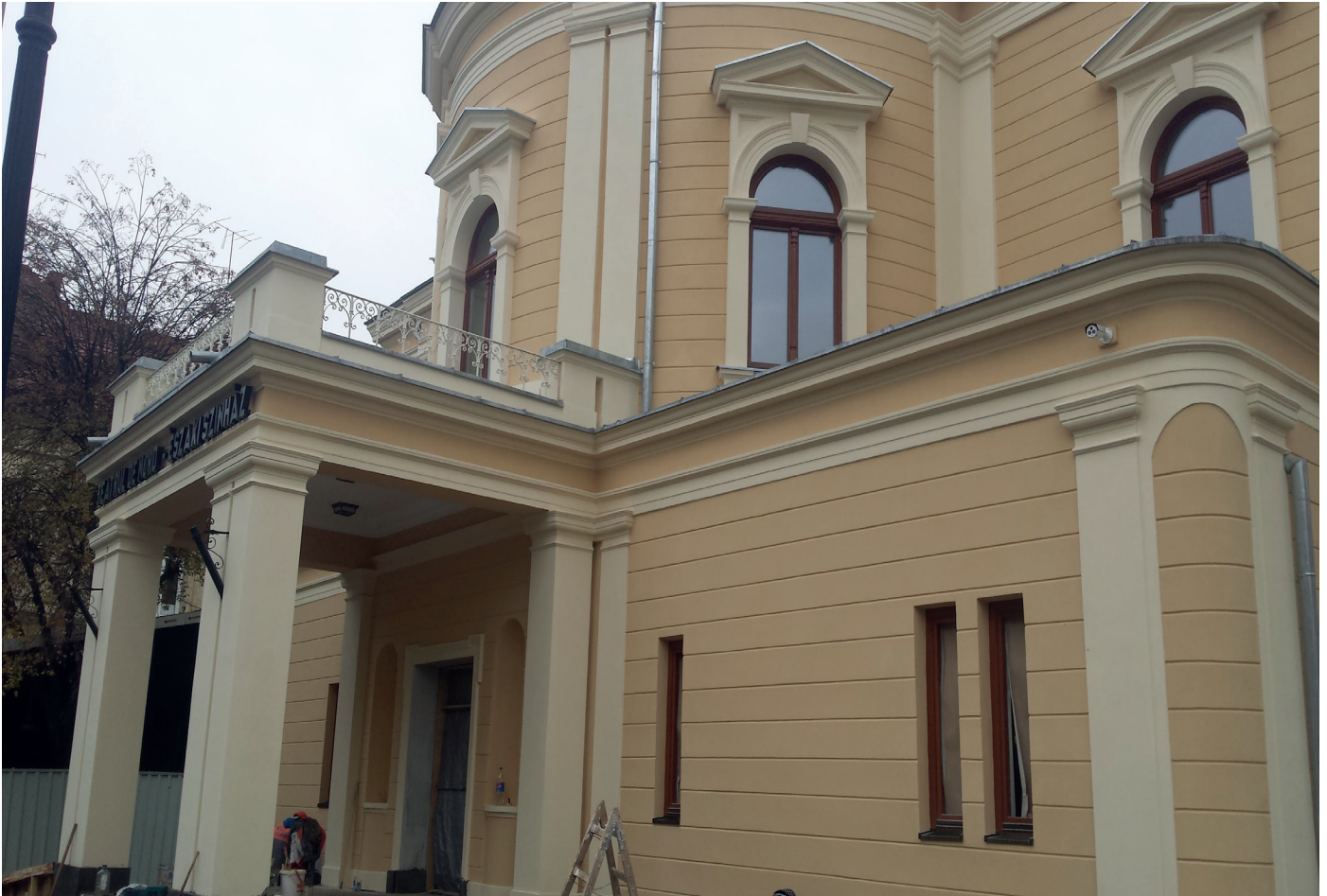
Sisteme renovare și asanare
