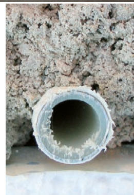
Chape au ciment conventionnelle
