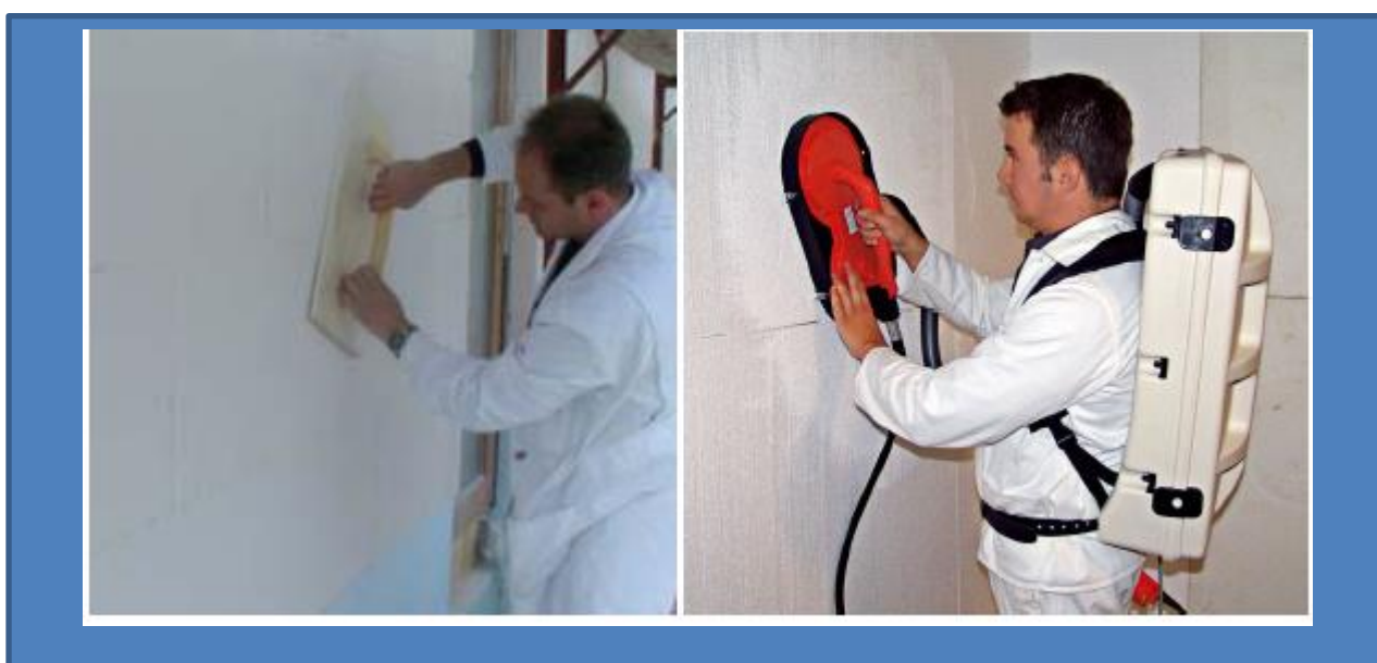
Obr 13 : Broušení desek
