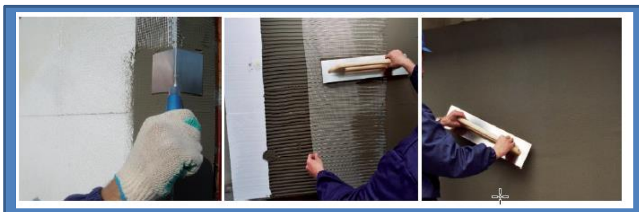
Obr 19: Vyztužení základní vrstvy
