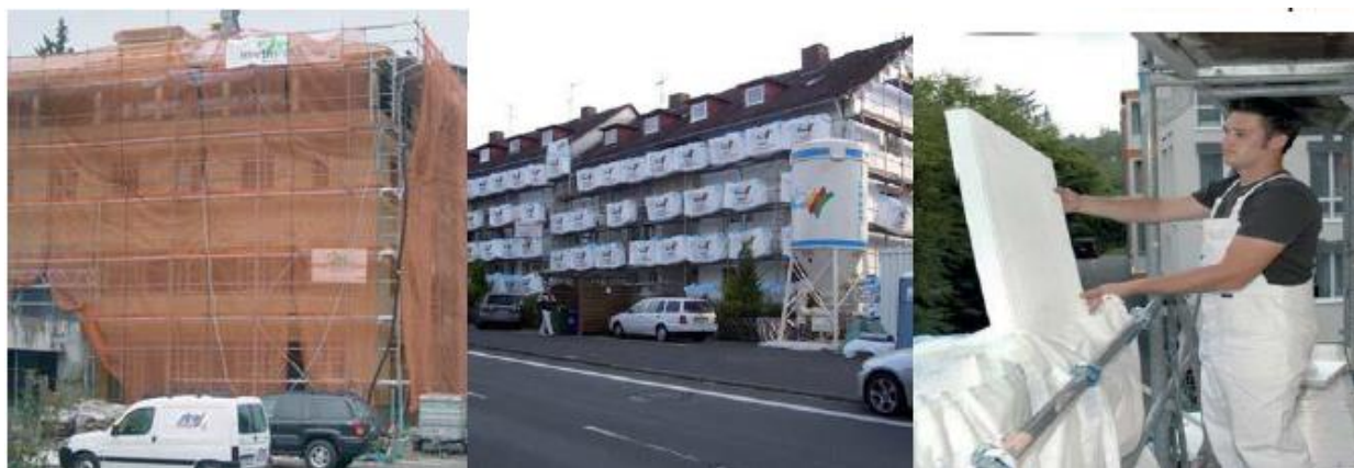
Obr 9: Lešení a ochranné sítě a vaky na materiál
