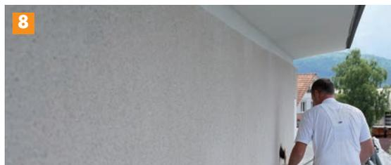
Dépoussiérer soigneusement la surface fraîchement grattée avec une brosse ou un balai souple et si nécessaire gratter immédiatement encore une fois.
