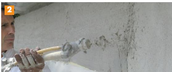
Appliquer la deuxième couche une fois que la première commence à sécher – en principe le jour suivant. De manière rationnelle, effectuer l'application couvrante avec une machine pour enduit fin. Lors de la mise en œuvre à la main, veiller à effectuer un travail rapide sans raccords.
