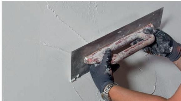
Le Fixit 764 Crépi à la truelle peut être projeté manuellement, indépendamment de la granulométrie, sur la colle et mortier d'enrobage fraîchement appliqué...
