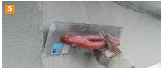
Avec le grattoir dentelé pointu Fixit S6 peigner légèrement l'enduit de finition minéral encore frais, afin de repérer les dernières poches d'air. Laisser durcir ainsi la structure de la surface finement dentée.
