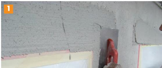
Spatuler la première couche au minimum dans l'épaisseur du grain, sans talocher. La surface doit ensuite être plane.
