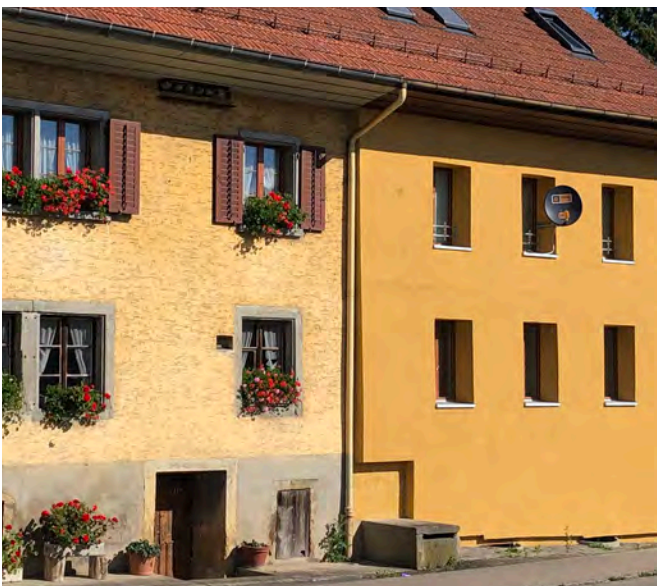
Die rechte Fassade wurde zwar neu gedämmt, jedoch ging dadurch die Geschichte des Hauses verloren.
