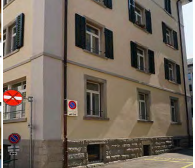
Streiflicht auf der Fassade mit Aerogeldämmputz; die Dämmung ist auf dieser Fassade nicht sichtbar.
