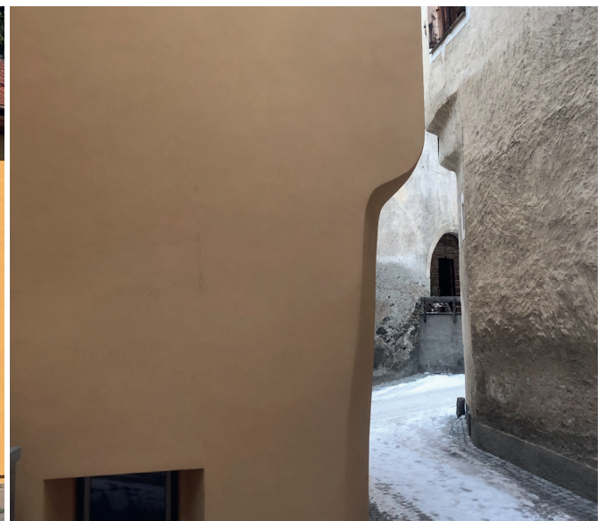
Hier erzählt die Fassade mit Aerogeldämmputz eine Geschichte, die weiterhin nachvollziehbar ist.
