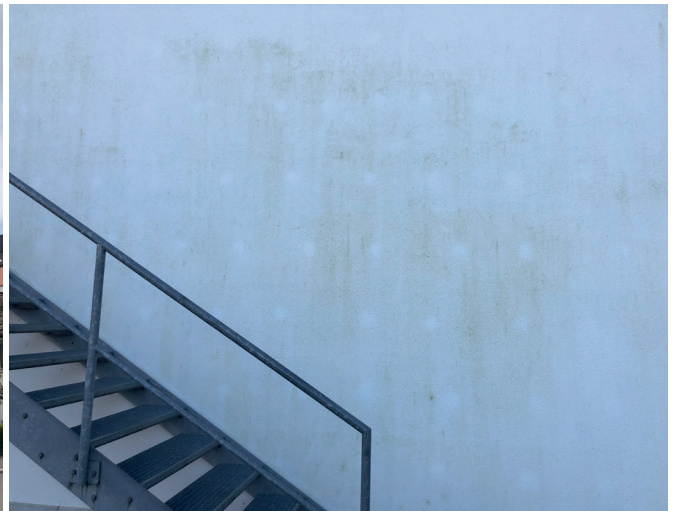
10-jährige Fassade mit verputzter AWD
