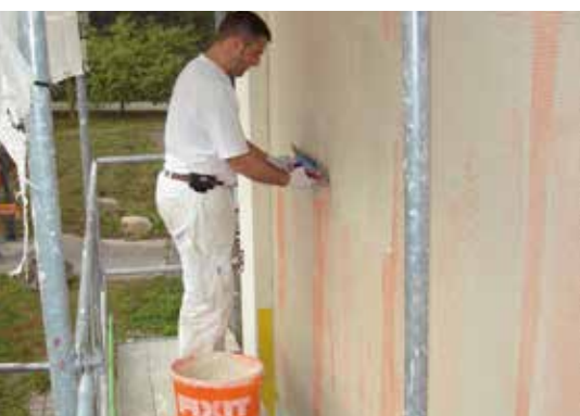
Grundputz mit Gewebereinbettung
