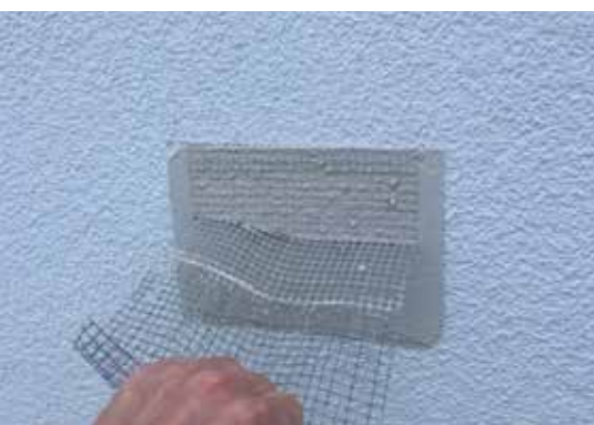
Vorbereitung der Abrissprobe
