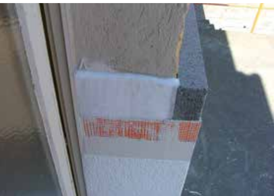
Leibung mit Aerogel und Putzaufbau
