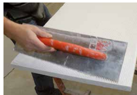
Auftragung des Klebers mittels Zahntraufel
