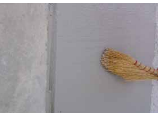
Aufräuen des Grundputzes mit dem Besen
