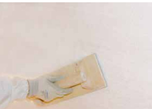
Oberfläche der EPS-Fassade schleifen
