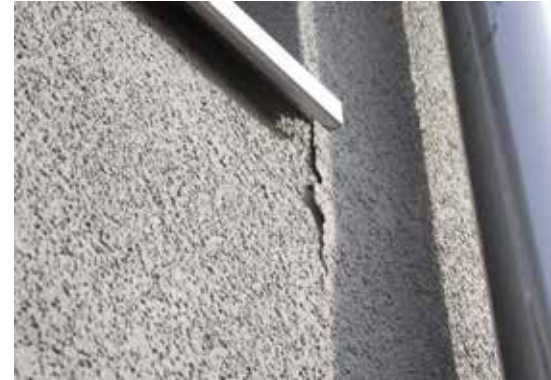
Grossflächige Aufwölbung und Blasenbildung
