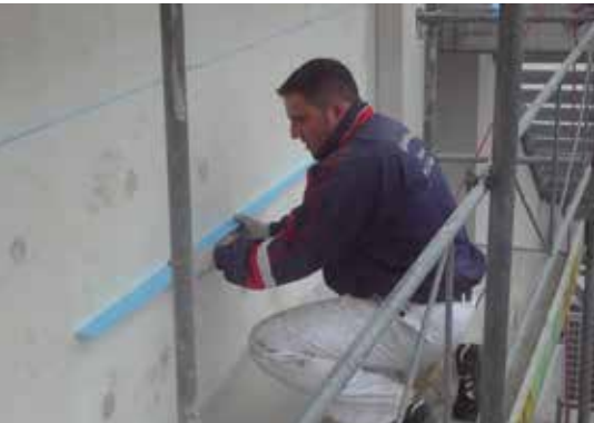
Offene Plattenstösse mit XPS-Keilen verschliessen
