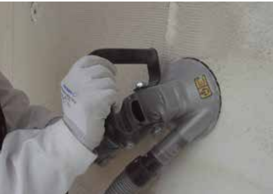
Abfräsen von Putzschichten
