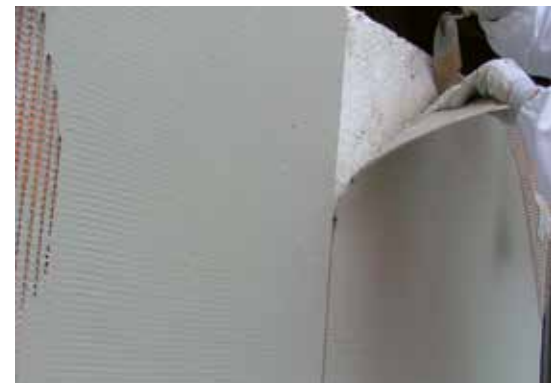
Abschälung der Einbettung von EPS-Platten
