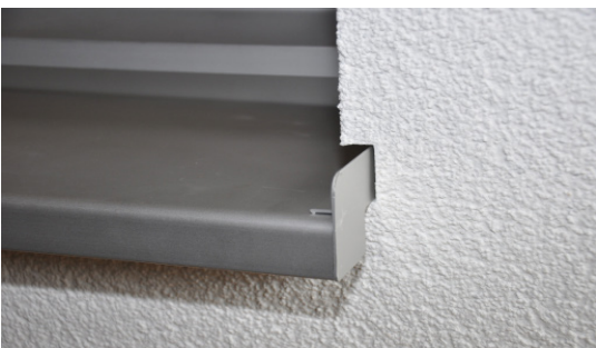
Sol-Pad : Pour le montage des appuis de fenêtre après réalisation du SITE.
