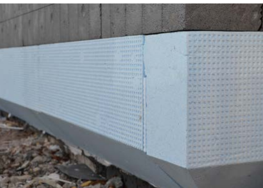
EPS 033 Sockelplatte 30, Coupe à 45° des plaques de socle
