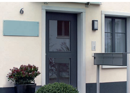
Exemples de charges légères sur l'isolation extérieure
