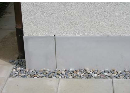
FIXITherm-élément de socle en fibro-béton disponible jusqu'à hauteur de 1200 mm.
