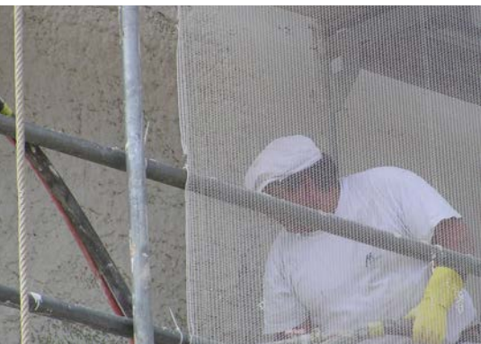
Bâtiment protégé contre la pluie et des températures basses.
