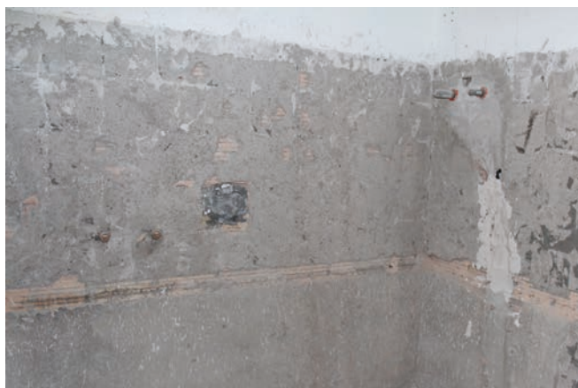
Les anciens carreaux ont été enlevés et Fixit 632 Rapid un enduit d'égalisation et de rénovation a été appliqué.
