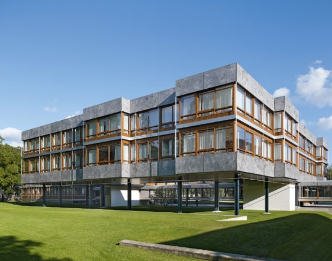
Rekonstruierte, denkmalgeschützte Fassade des Bundesverfassungsgerichts nach Schadstoffsanierung
