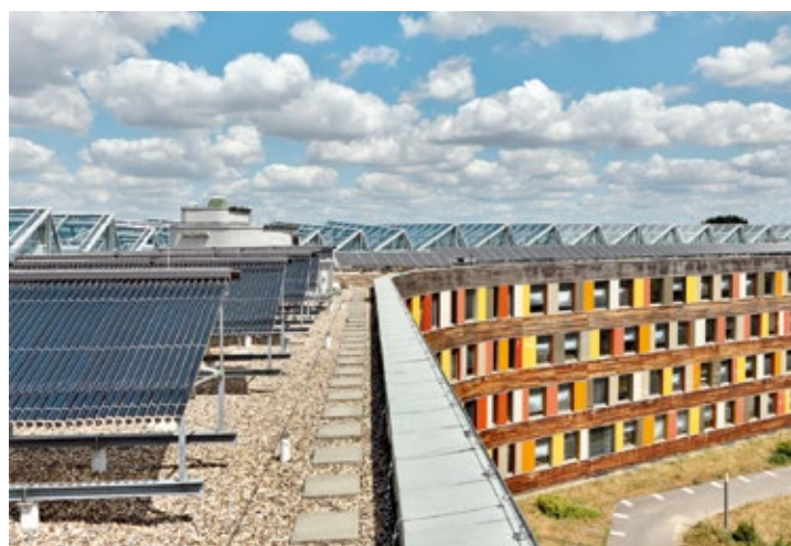
Solargestützte Energieerzeugung auf dem Hauptgebäude des Umweltbundesamtes Dessau
