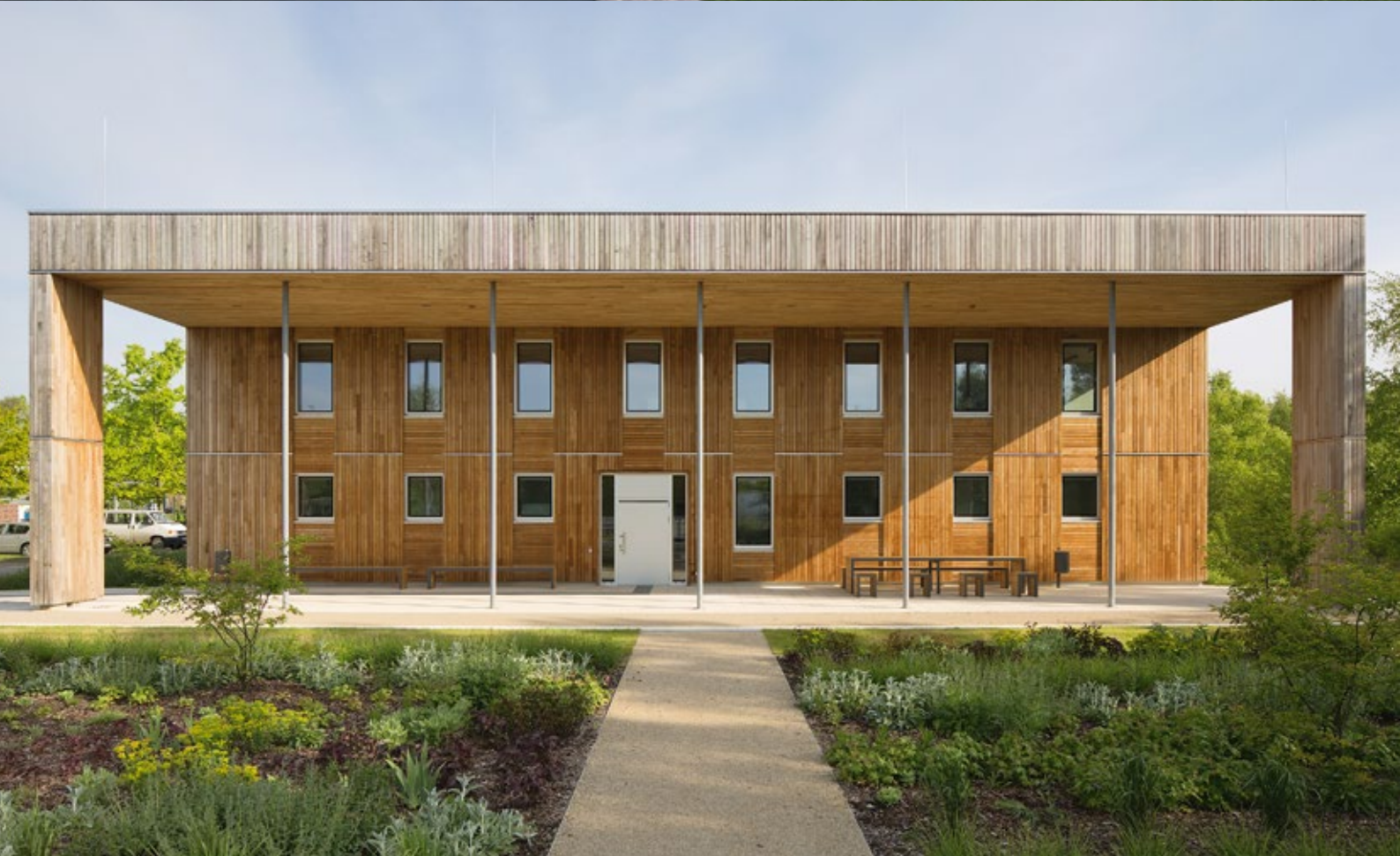
Oben: Komplettmodernisierung des denkmalgeschützten Gebäudes des Bundesverfassungsgerichts in Karlsruhe Unten: Erstes Bundesgebäude mit begleitender BNB-Anwendung in allen Leistungsphasen, Umweltbundesamt Haus 2019
