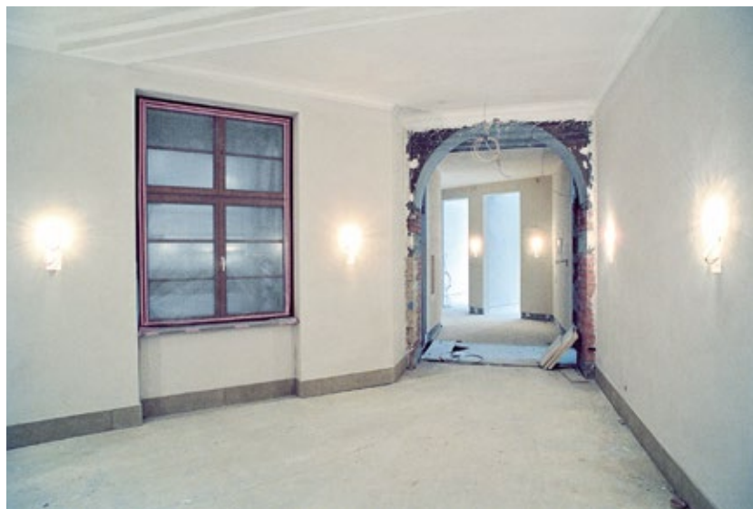
Übergang vom Alt- zum Neubau im Gebäude des BMUB in der Stresemannstraße während der Baumaßnahme
