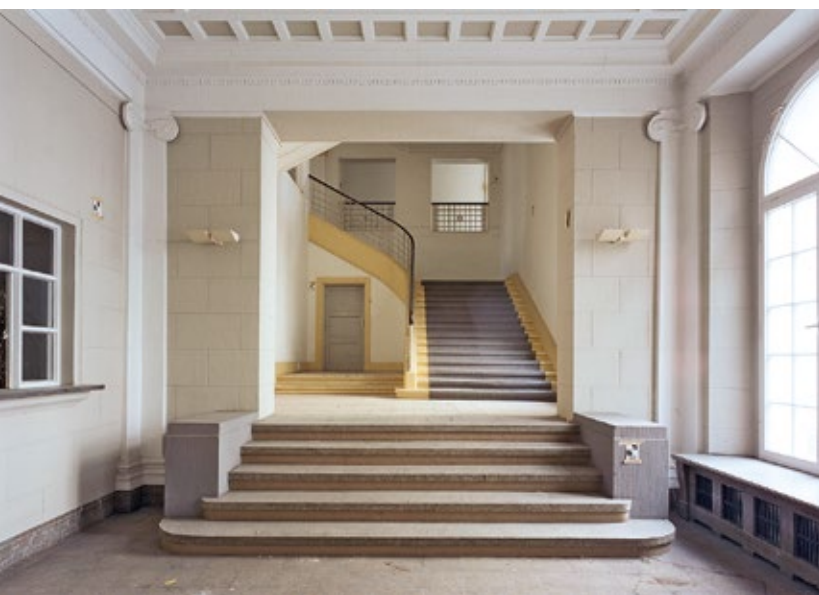
Vor dem Hintergrund der vielfältigen Nutzungsgeschichte wurde das Foyer des Altbaus des BMUB in der Stresemannstraße 128 mit hohem denkmalpflegerischen Anspruch wieder hergestellt.
