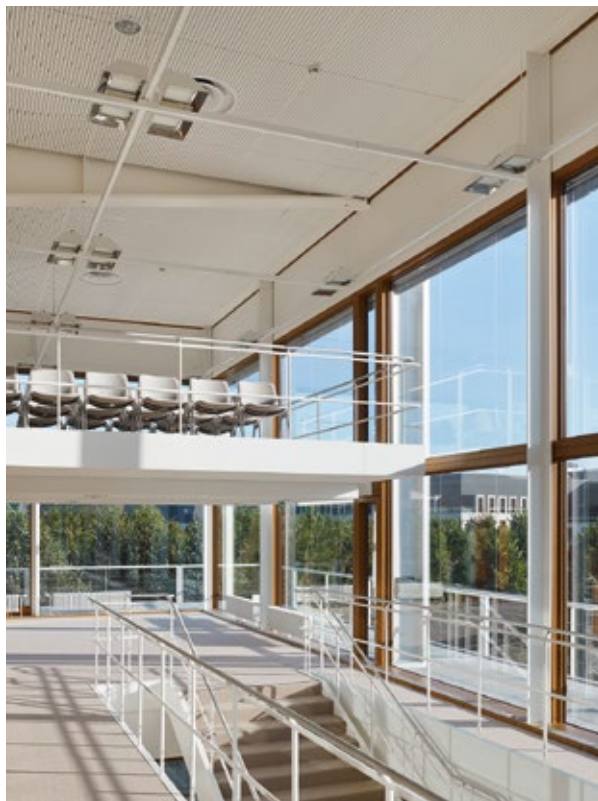
Erhaltung der hohen Gestaltungs- und Nutzungsqualität bei der Komplettmodernisierung des Bundesverfassungsgerichts in Karlsruhe
