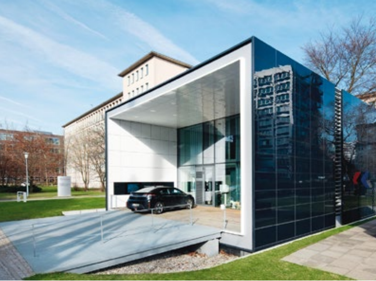
Pilotprojekt des BMUB zur Umsetzung der Effizienzhaus Plus-Anforderungen
