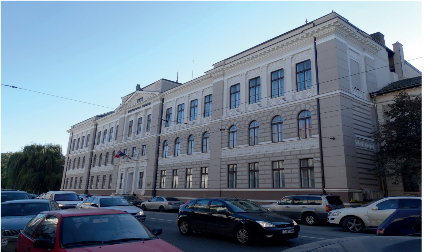
Sisteme renovare și asanare
